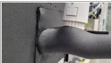
Abb. 8: Verrohrung bauseitig isolieren
