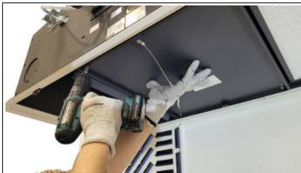
Abb. 21: Revisionsabdeckung lösen
