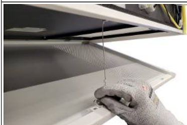
Abb. 18: Sicherungsseil einhängen
