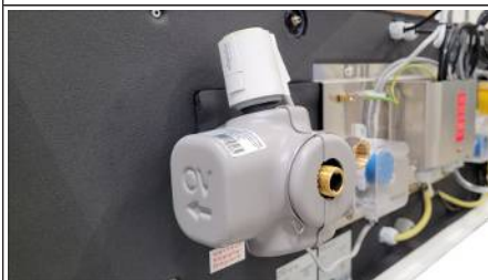
Abb. 9: Dämmschale bei DDU Ventil verkleben
