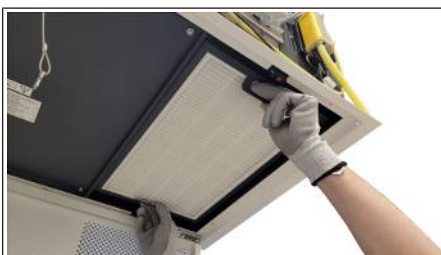
Abb. 19: Ansaugfilter herausnehmen
