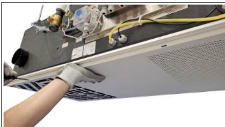
Abb. 17: Revisionsklappe öffnen
